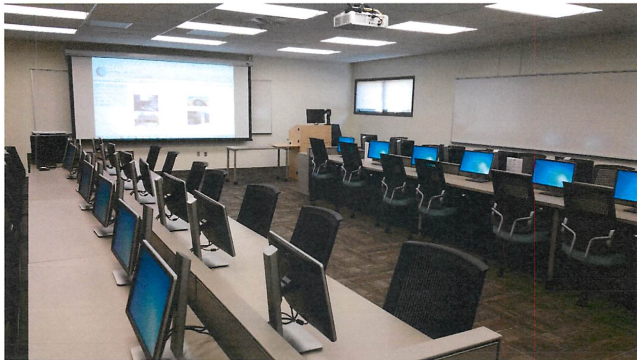
Computer & AV System Installed & Tested – Computer Lab.
